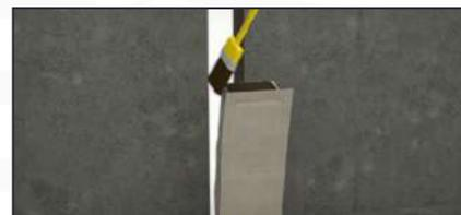
Para unir dos módulos de capa, aplique la cola en los extremos de ambos módulos y colóquelos, firmemente, uno tras otro.
