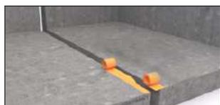
Coloque una cinta adhesiva de limpieza sobre los bordes de la junta. Pegue el interior de la junta con la cola VEDACOLLE<sup>®</sup>.
