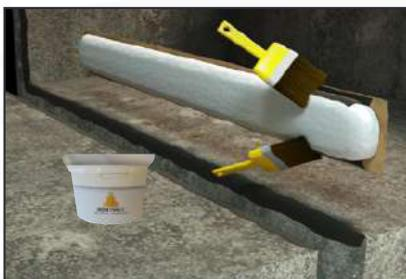
Encole la parte de abajo de las aletas así como la parte vertical de la capa, sobre una anchura de 6 cm.
