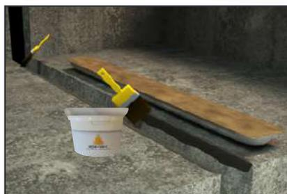
Encole los dos lados de la junta sobre 100 mm de altura así como un ancho de 5 cm en la parte superior del hormigón, con la cola VEDACOLLE<sup>®</sup>.
