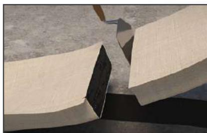
Para unir dos módulos de capa, aplique cola en los extremos de ambos módulos (para las juntas > 100 mm el método de unión es diferente).
